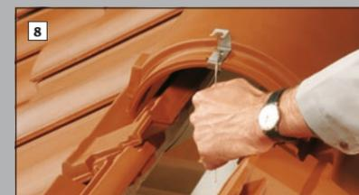
8 Der Draht wird mit der Hand nach oben gezogen (gespannt) und anschließend nach unten abgebogen. Dadurch verkragt sich der Draht im Führungsschlitz der Firstklammer.
