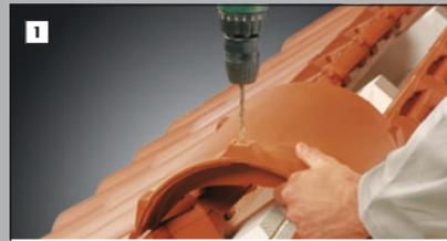
Bohrung eines 6 mm Lochs durch die keramische Erhebung am Firstziegel für die Befestigung der Funktionsanfang- und -endscheibe.
