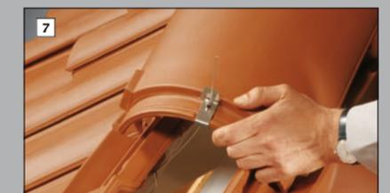
7 Der Firstklammerdraht wird durch den vorgelochten Firstziegel und die aufgesteckte Edelstahl-Firstklammer geführt.
