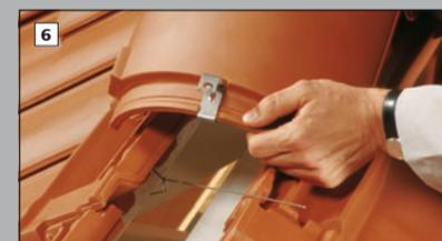
6 Die Edelstahl-Firstklammer kann beim Montieren durch ihre Passgenauigkeit und Federkraft nicht mehr vom Firstziegel abfallen.
