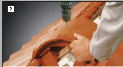
Der Firstziegel wird am Scheitelpunkt im äusseren Drittel für das Aufnehmen des zusätzlichen Firstklammerdrahtes gebohrt (6 mm Bohrer).
