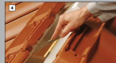
4 Der Firstklammerdraht wird nach dem Einhängen in die Lattung geschlossen.
