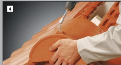
Die Funktionsanfang- und -endscheibe wird mit der beiliegenden, selbstschneidenden Edelstahlschraube mit einem Steckschlüssel SW 3/8 Zoll befestigt.
