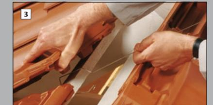
3 Leichtes Anheben des Firstanschluss-Lüfterziegels erleichtert das Einhängen des Drahtes. Alternativ kann der Firstklammerdraht vor dem Auflegen der Firstanschluss-Lüfterziegel eingehängt werden.
