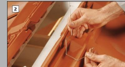
2 Zur einfachen Installation des Drahtes wird dieser aufgebogen und in Abständen von ca. 42 cm in die letzte Dachlatte (rechts und links im Wechsel) eingehängt.
