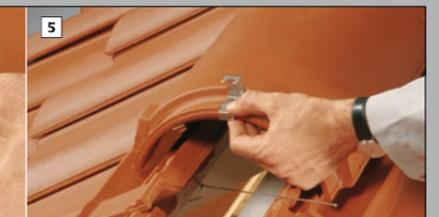
5 Aufstecken der Edelstahl-Firstklammer auf die Verfalzung des Firstziegels.
